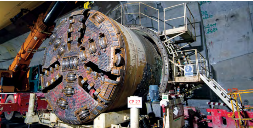
Excavation of cross passages using mini TBMs – a FIRST in the city 團隊以小型隧道鑽挖機建造連接通道，創下香港隧道工程的先河
