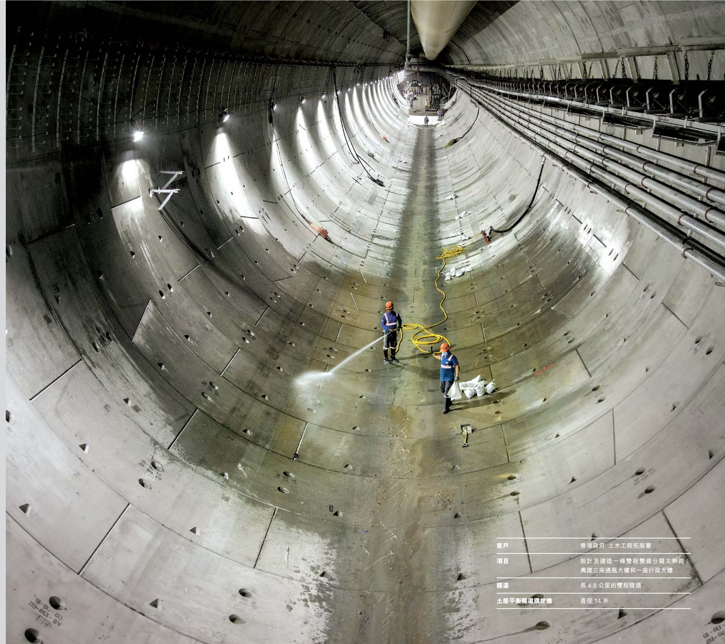
4: Technical FIRST: Tunnel Boring Machine (TBM) 180-degree U-turn operation completed within 3 months' time 香港隧道史上的第一次：工程團隊成功在 3 個月內於隧道內完成鑽挖機 180 度轉向
