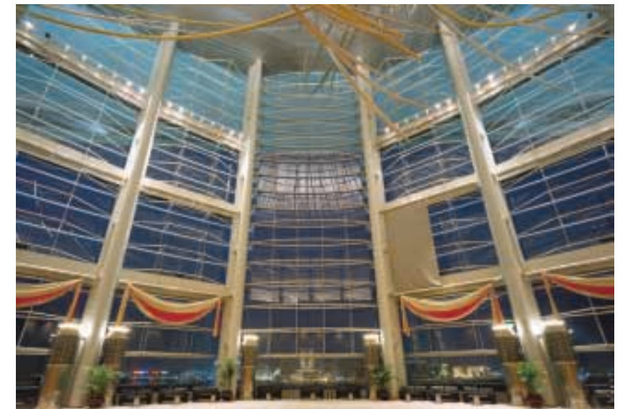
The 30m high glass façade of the Grand Foyer is one of the largest windows in the world 新翼大會堂前廳的向海玻璃幕牆高 30 米，是全球最大幅的玻璃幕牆之一
