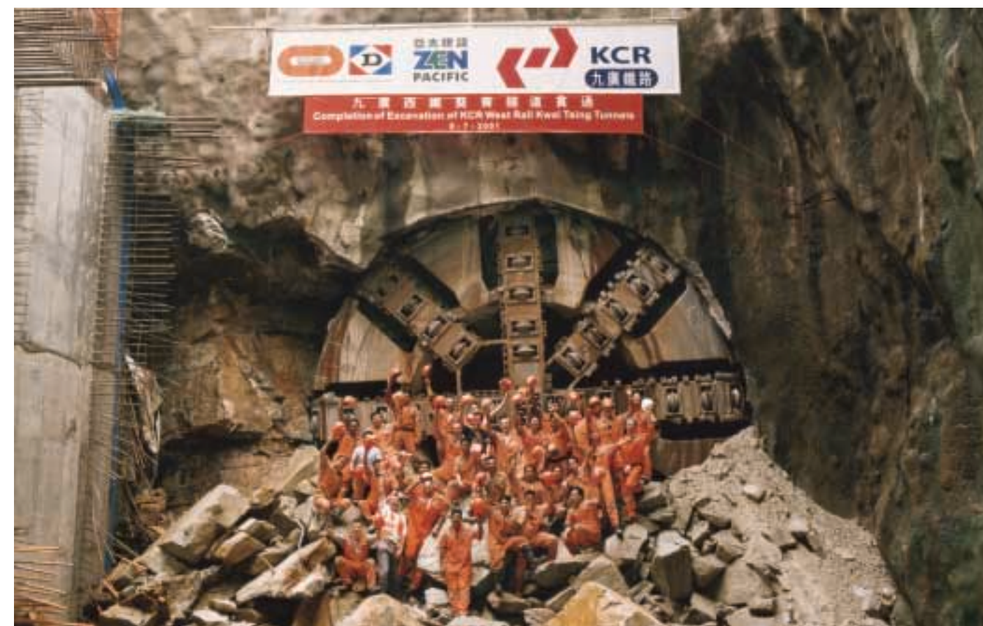
The tunnel broke through in 2001 葵青隧道的鑽挖工程於 2001 年完成
