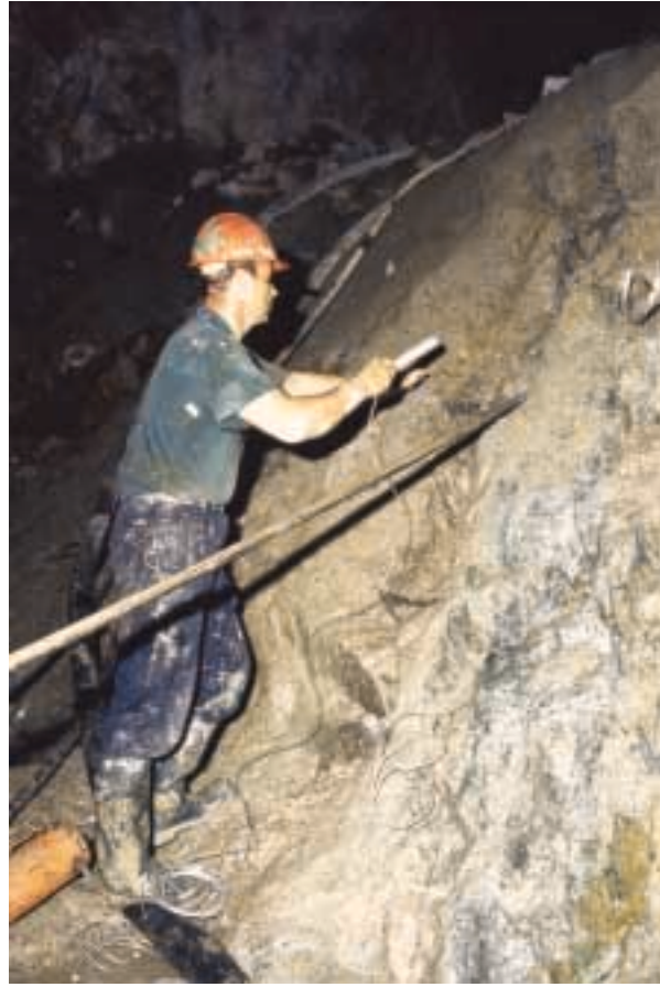
Loading explosives at the drill holes 在鑽孔注入爆炸品
