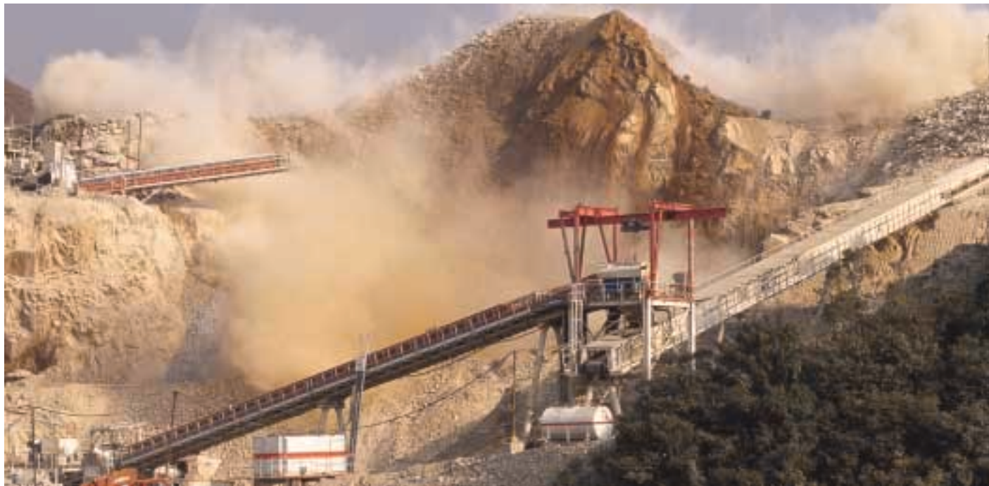
Blasting of the tunnel 隧道爆破工程
