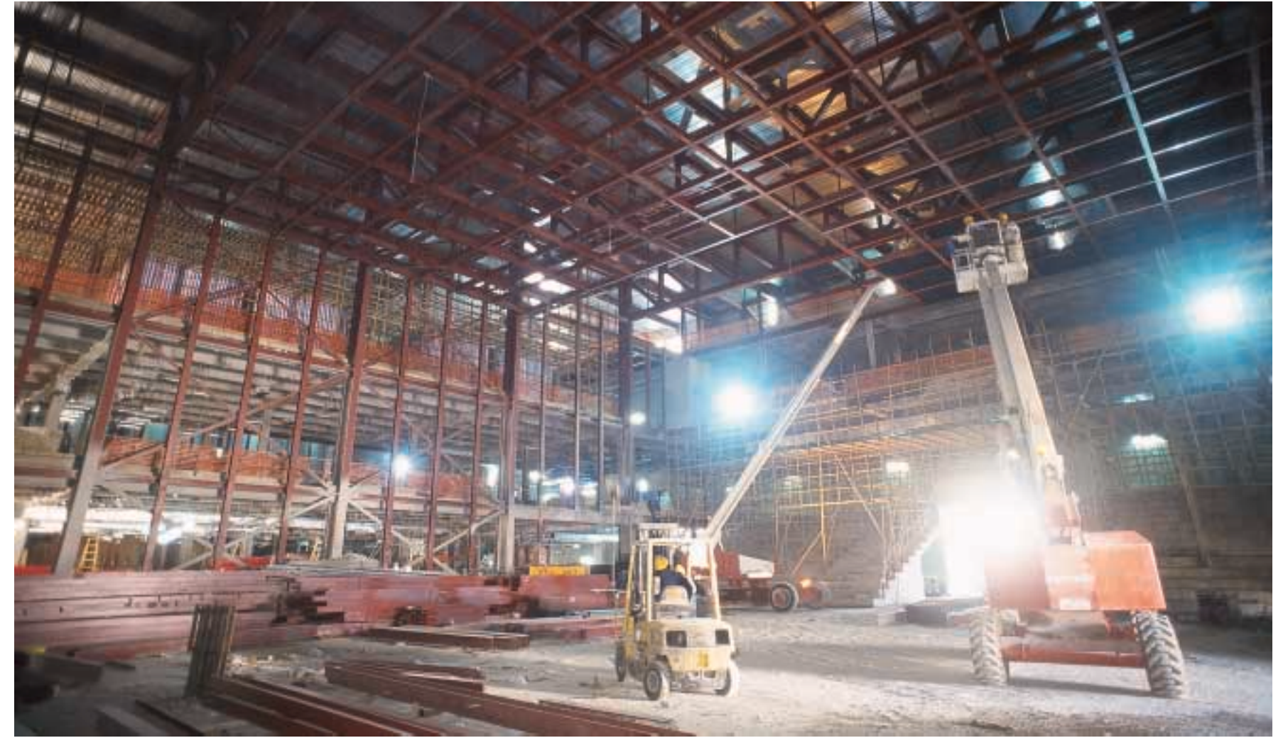
Installation of specialist E&M works into the 18 metre-high ceilings 機電工程人員在 18 米高的天花安裝設施
