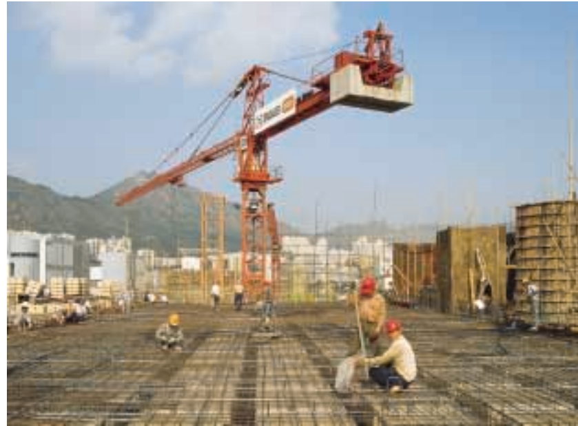
Preparing to pour the concrete 準備就緒，注入混凝土
