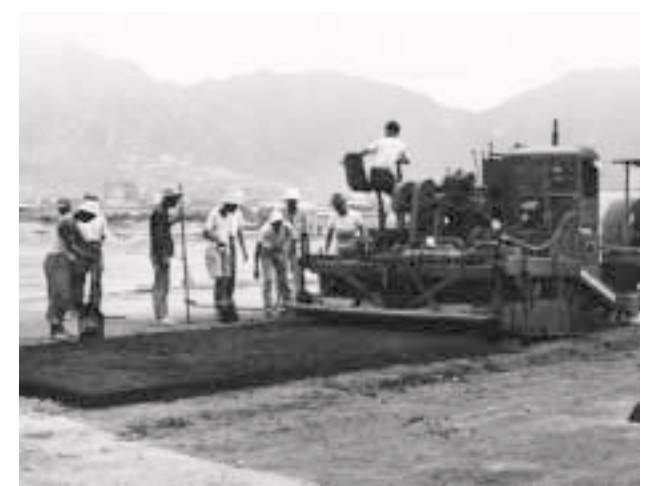
Asphalting the runway 在跑道上鋪上瀝青
