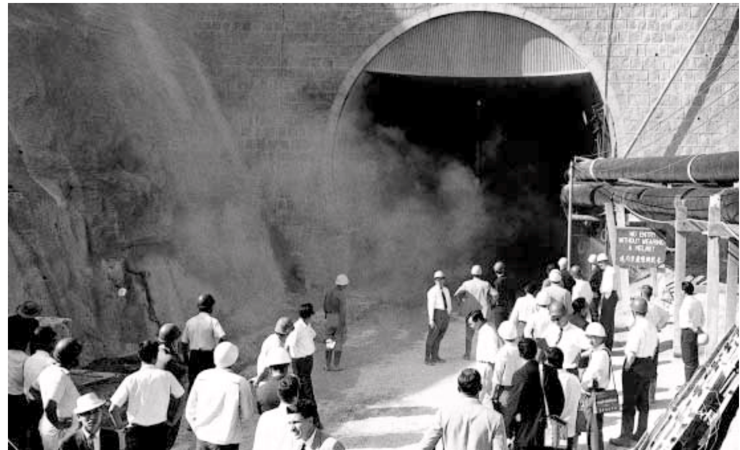
Tunnel blasting was completed in 1963 1963年，最後一次爆破工程
