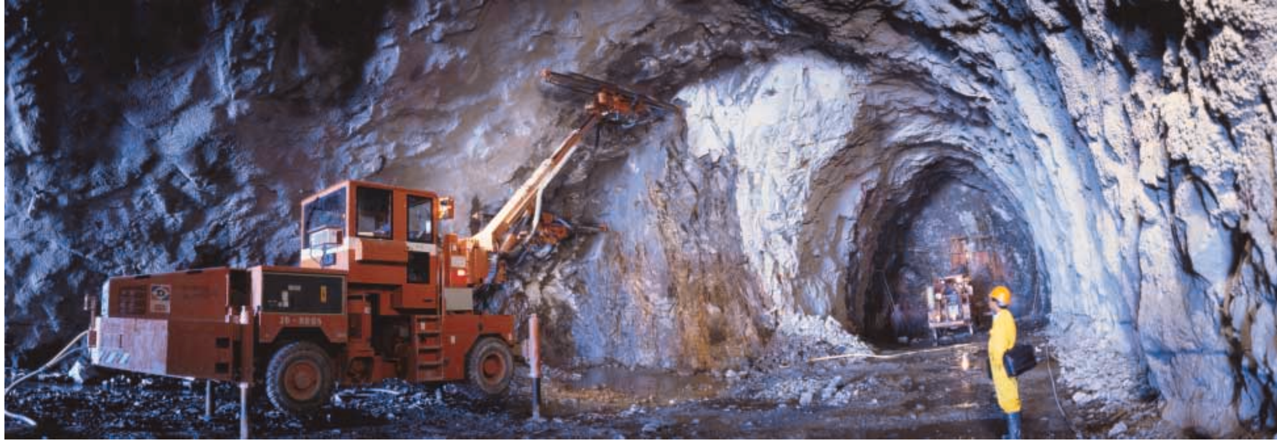
Computerised jumbo drilling machines 電腦化隧道鑽孔機
