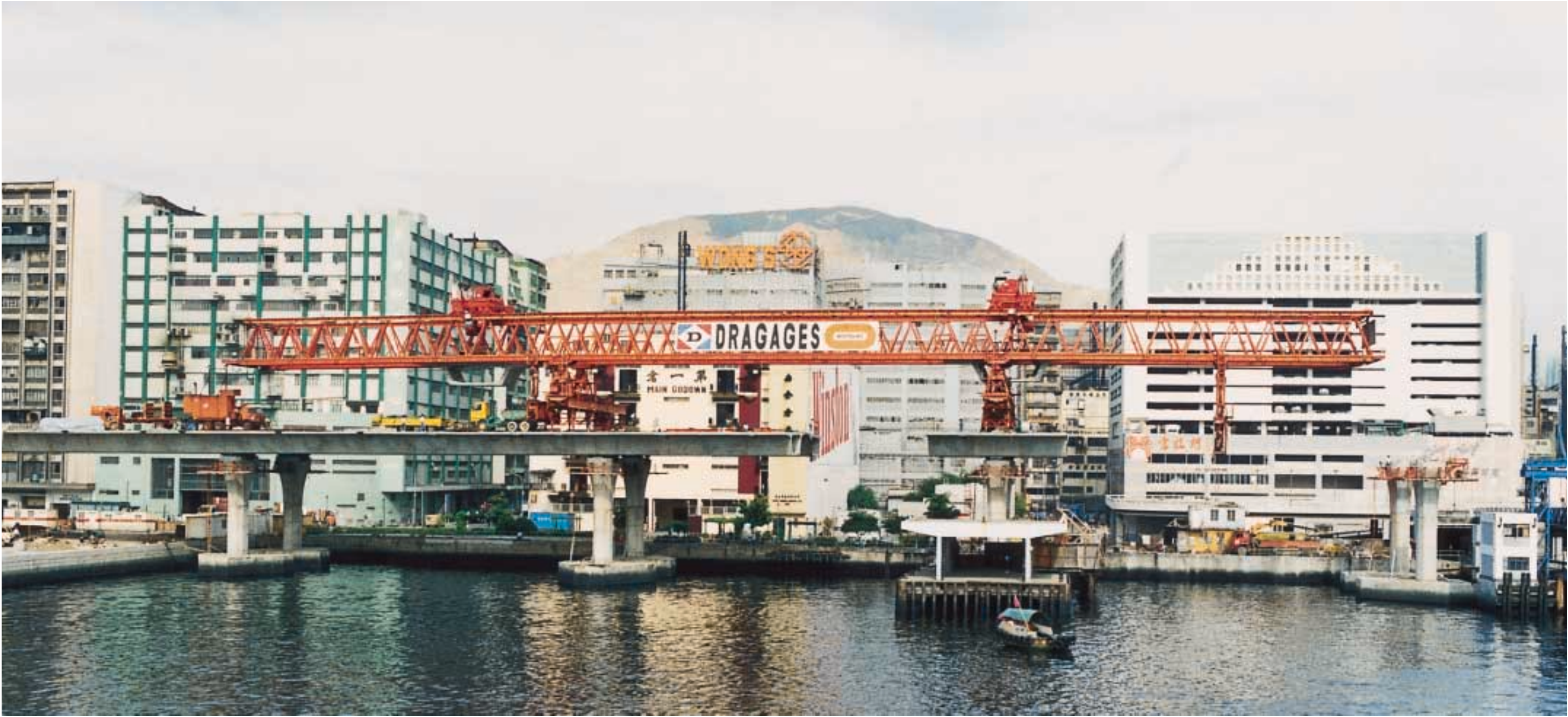
The 120-metre launching girder weighed 450 tonnes 曳進吊樑機全長 120 米，重 450 噸
